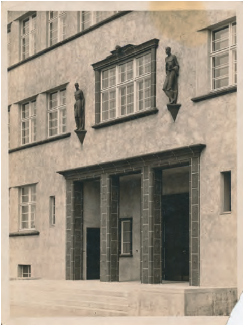
Abb. 16: Staatliches Kaiser-Wilhelm-Gymnasium, Berlin-Neukölln, 1929. Heute Kepler-Oberschule, Zwillingestraße 21. © Nachlass Gerhard Schliepstein. Foto: Fritz Bettge, Berlin
